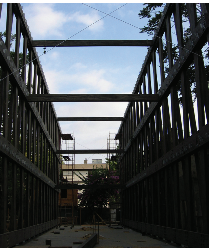
Estructura soportante (Fuente : Plataforma Arquitectura)
