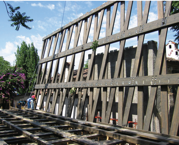
Montaje estructuras laterales (Fuente : Plataforma Arquitectura)
