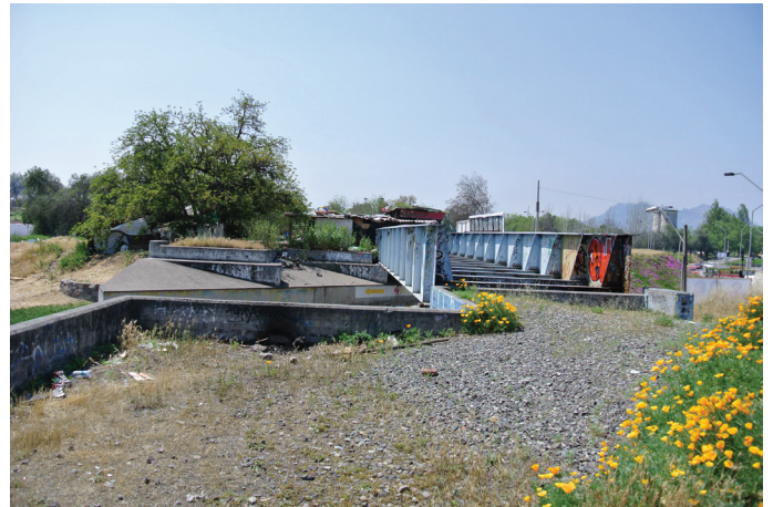
Puente preexistente sobre Roman Spech
