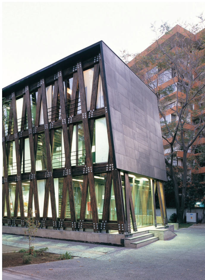
Edificio BIP - Albertó Mozo Foto : Cristóbal Palma
